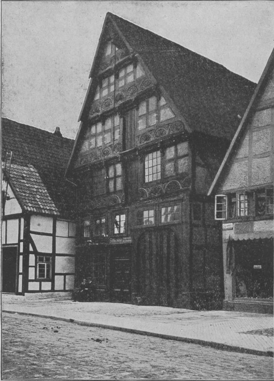
Fachwerkhaus an der Langenstraße Nr. 41.
