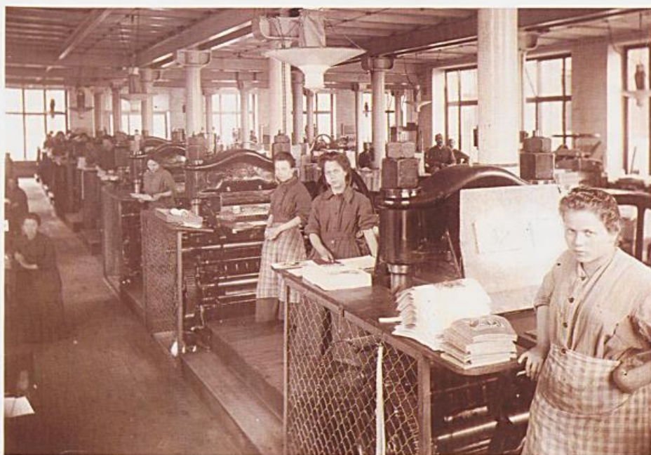
Blick in die Prägerei
