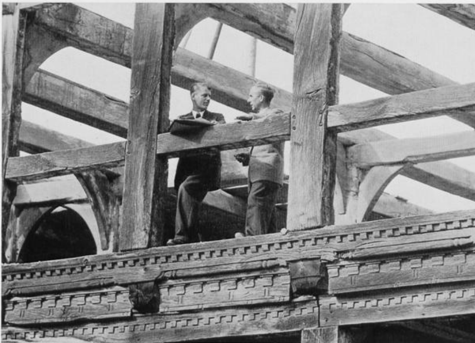
120. Vorkragung des Kornhauses in Schieder. Die Hölzer zeigen das gleiche Zahnschnittmuster, das Ende des 16. Jahrhunderts der Zimmermeister Iggenhausen am Fachwerkbau des Schlosses Oesterholz (Kr. Detmold) anbrachte.
