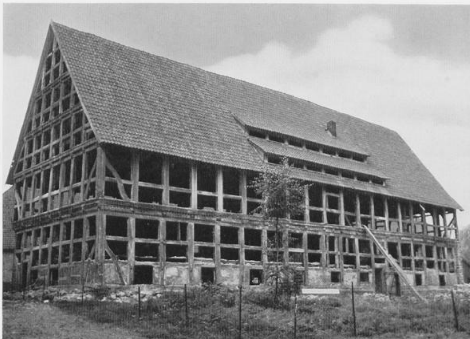
114. Das Balkengerüst des Kornhauses in Schieder nach Entfernung der Ausfachungen vor dem Abbau im Herbst 1955.
