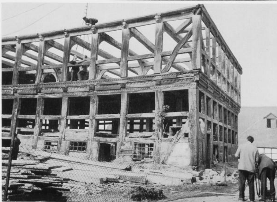
115. Der Abbau des Kornhauses wurde in Filmaufnahmen dokumentiert.
