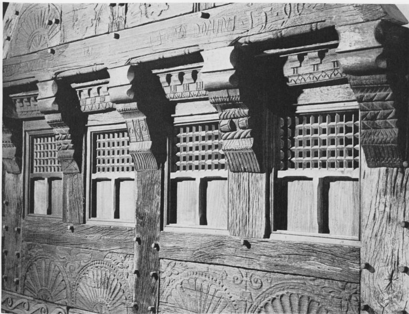
6. Schnitzgiebel des Hauses von Hermann Pott und Lucia Schlue aus Schwabenberg (Kr. Detmold) vom Jahre 1590 mit Fächerrosetten, geschnitzten Balkenstützen („Knaggen“) und Lüftungsfenstern für den Dachboden.
