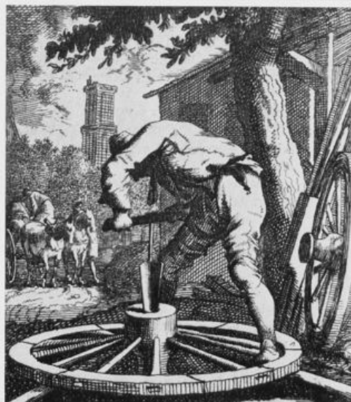
14. Nabenbohrer und Radbock aus einer Lemgoer Wagenbauerwerkstatt. Noch zu Anfang dieses Jahrhunderts war die Alte Hansestadt Lemgo in Ostwestfalen führend im Kutschenbau.
