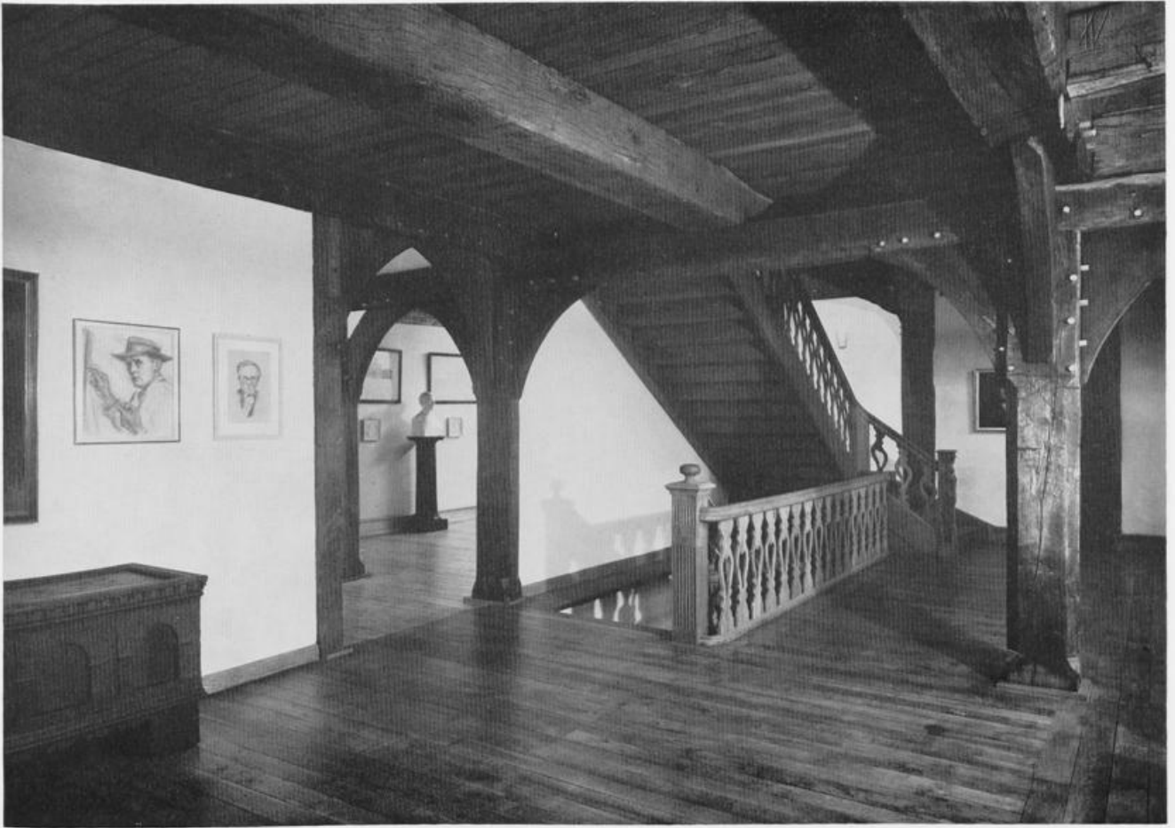
28. Oberes Treppenhaus im ehemaligen Kornhaus aus Schieder. Das Treppengeländer stammt aus einem Detmolder Bürgerhaus des 18. Jahrhunderts. Am rechten Balkenständer sind die Eichennägel erkennbar, die das Gebälk des Fachwerkhäuses zusammenhalten. Zur Verzimmerung des gesamten Balkengerüsts des Kornhauses wurden rund 3000 solcher Eichennägel verwendet.
