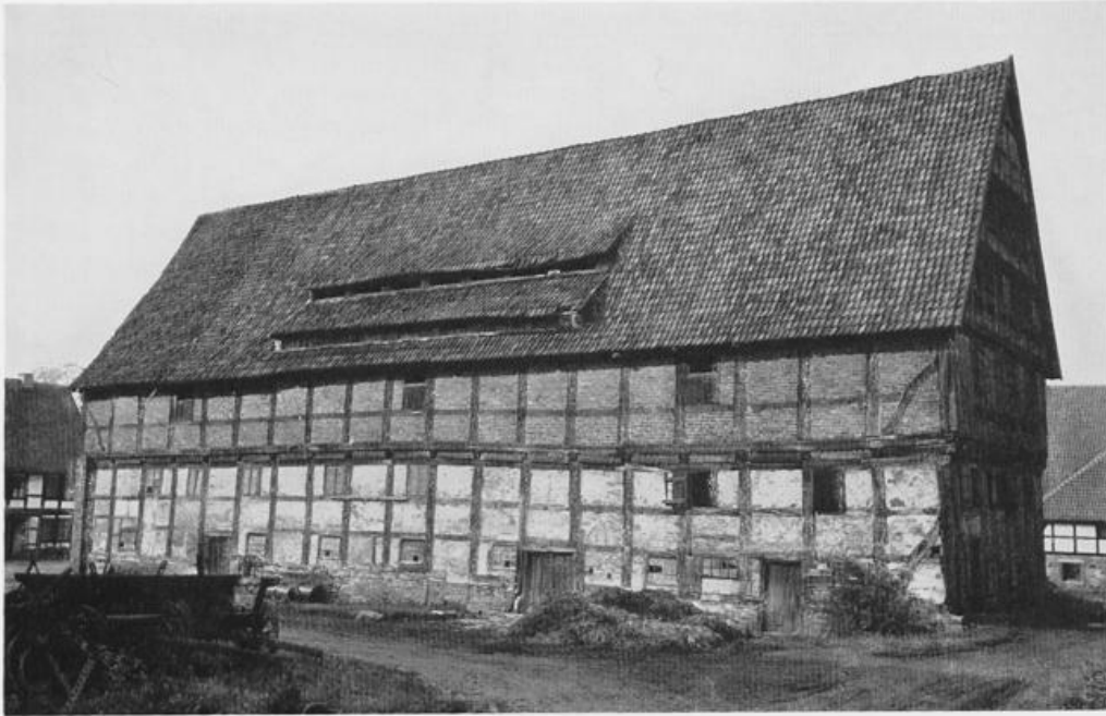
2. Kornhaus der Domäne Schieder (Kreis Detmold), erbaut um 1590 vom Zimmermeister Iggenhausen im Auftrage des Grafen Simon VI. zur Lippe (1554—1613), um darin das vom Landvolk abgelieferte Zehntkorn zu lagern. Mit seinem über 17 m hohen Schnitzgiebel und den fünf Geschossen von 36 m Länge zählt das Kornhaus zu den größten Fachwerkbauten Lippes.
