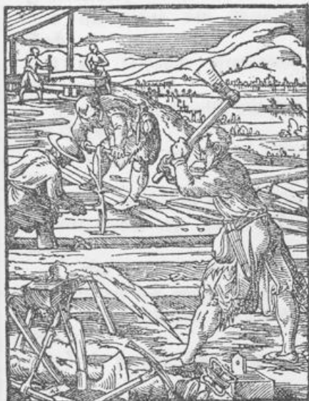
Zimmerleute auf dem Bauplatz. Holzschnitt von Jost Amman aus dem Jahre 1568.
