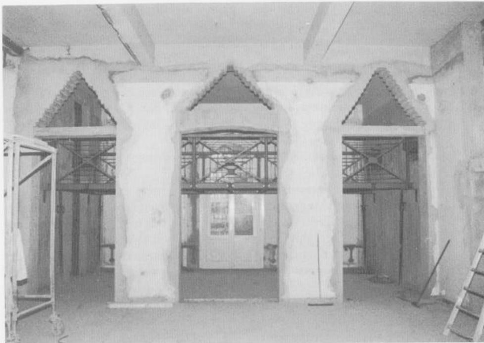
Umbau 1992 Mauerdurchbrüche und Empore im Eingangsbereich
