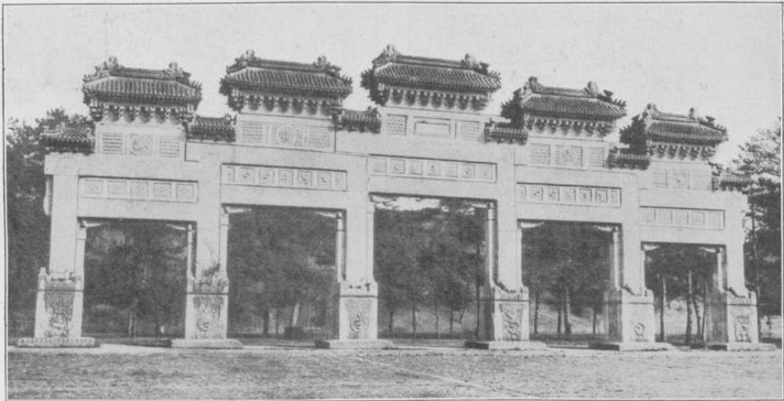
Abb. 125 Eines der drei fünfteiligen Eingangstore, Marmor mit Relief und fünf Torbegründungen mit Ziegeldächern, zum Tailing, dem Grabe Kaisers Yungcheng, 1723—1730, westliche Kaisergräber, Siling bei Peking (Aus: v. Mumm, Ein Tagebuch in Bildern)
