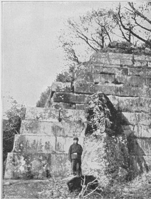
Abb. 87 Ecke mit Stützpfeiler von der Stufenpyramide (Bd. I, Abb. 9) des Marschall bei Tongku am Yalufluß Etwa 5. Jahrhundert (Aus: Chavannes, Les monuments de l'ancien royaume Coréen de Kao-Keou-li)
