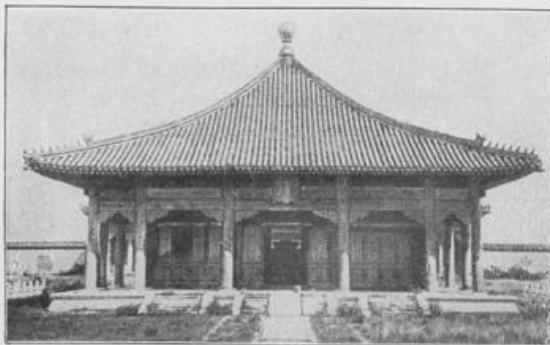
Abb. 51 Mittlere Audienzhalle, Chunghotien, mit fünfteiligem Zugang und vierseitigem Ziegeldach mit Knopfabschluß, im Kaiserpalast Peking (Aus: v. Mumm, Ein Tagebuch in Bildern)
