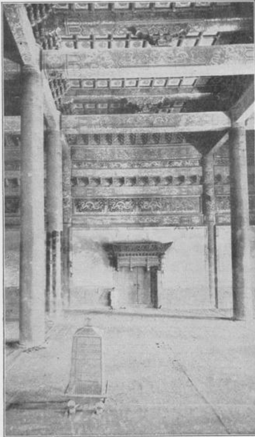
Abb. 53 Inneres, runde Holzsäulen ohne Platte und Kapitell tragen die Deckbalken zwischen den erhöhten Kassettendecken, bunt bemalt mit Drachenornamenten, Doppeltür mit eigenartiger Gesimsverzierung in Holz
