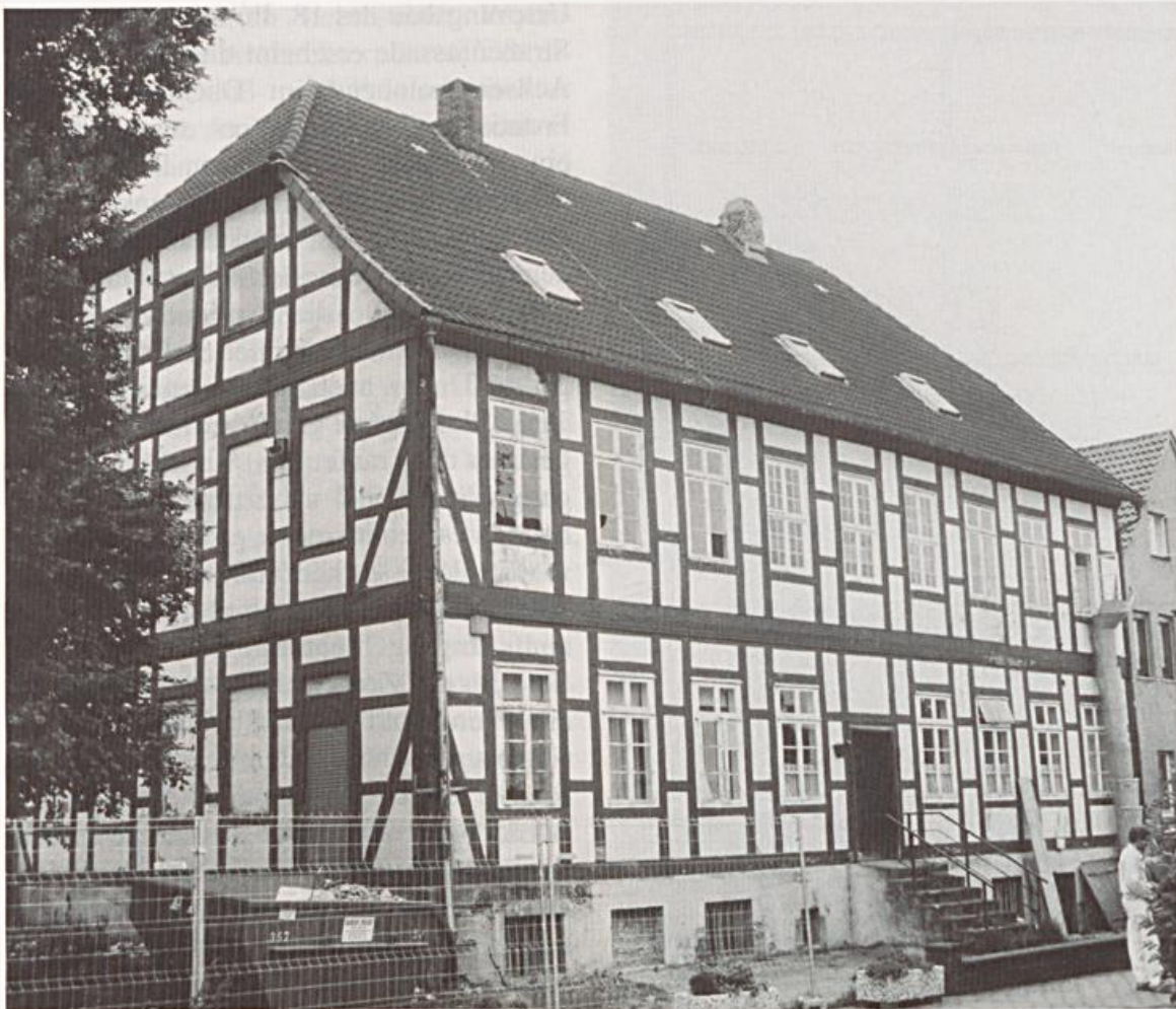
Abb. 2: Ansicht Nordfassade, Zustand 1992
