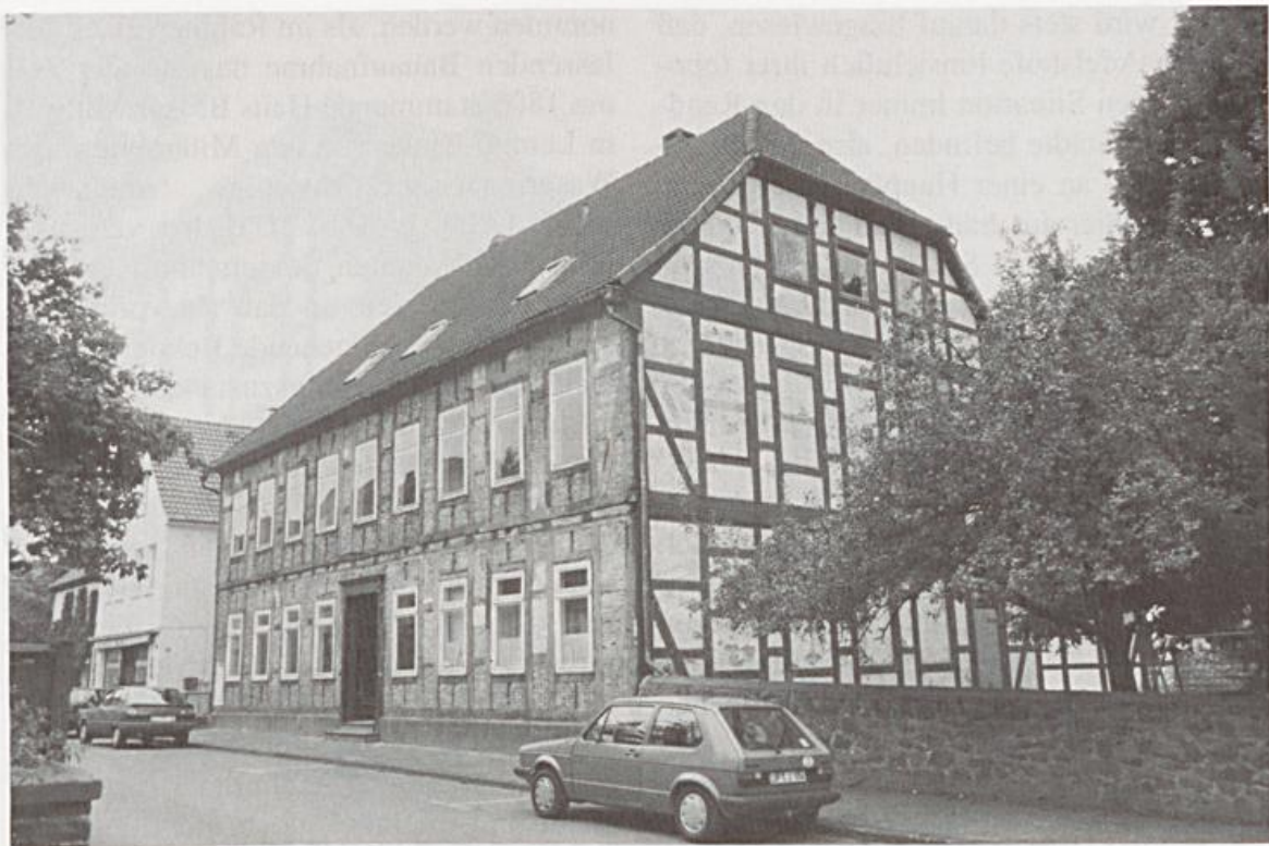
Abb. 1: Ansicht Süd- und Ostfassade, Zustand 1992
