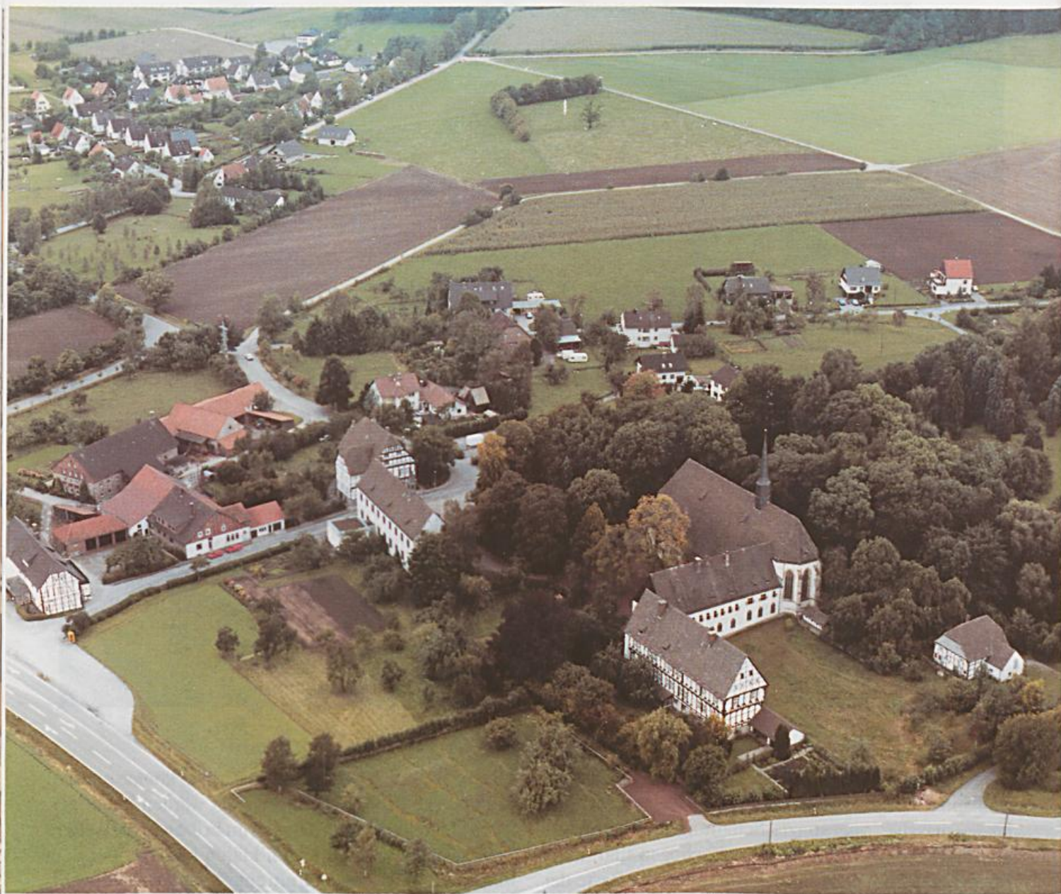
Falkenhagen. Das graue Kirchendach mit dem Dachreiter kennzeichnet die Klosterkirche. Die hohen, gotischen Fenster schmücken den Chor. Vom Klosterhof mit dem Kreuzgang ist das rechtwinklig an die Kirche anschließende Gebäude erhalten. Wieder im rechten Winkel dazu schließt sich der zweistöckige Fachwerkbau des evangelischen Pfarrhauses an. Das Jesuitenhaus mit der katholischen Kirche liegt westlich des baumbestandenen Klosterhofes. Man schaut von SO nach NW auf die Klosteranlage. Hinten links im Bild sieht man die meist neueren Häuser des Ortsteiles Glashütte.
