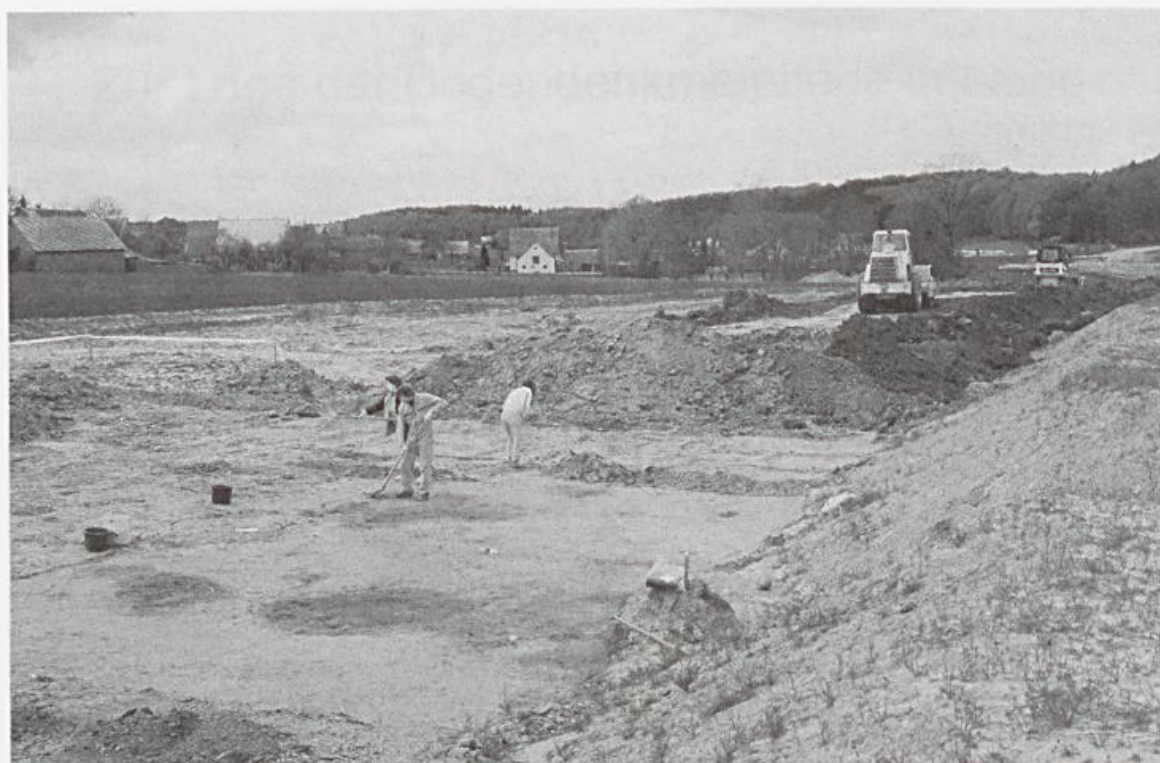
Horn-Bad Meinberg, Vahlhausen. Archäologie und Straßenbau. Beim Bau der B 1 neu konnten die Reste einer frühmittelalterlichen Hofstelle in einer Notuntersuchung erfaßt werden.
