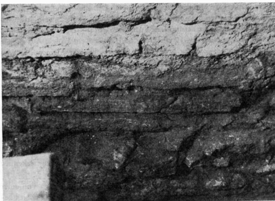
Abb. 8 Das Mauerwerk: Südmauer der Westvorhalle
