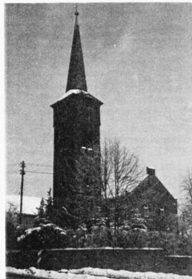
Der anstelle der abgerissenen Kapelle errichtete Glockenturm in Großenmarpe
