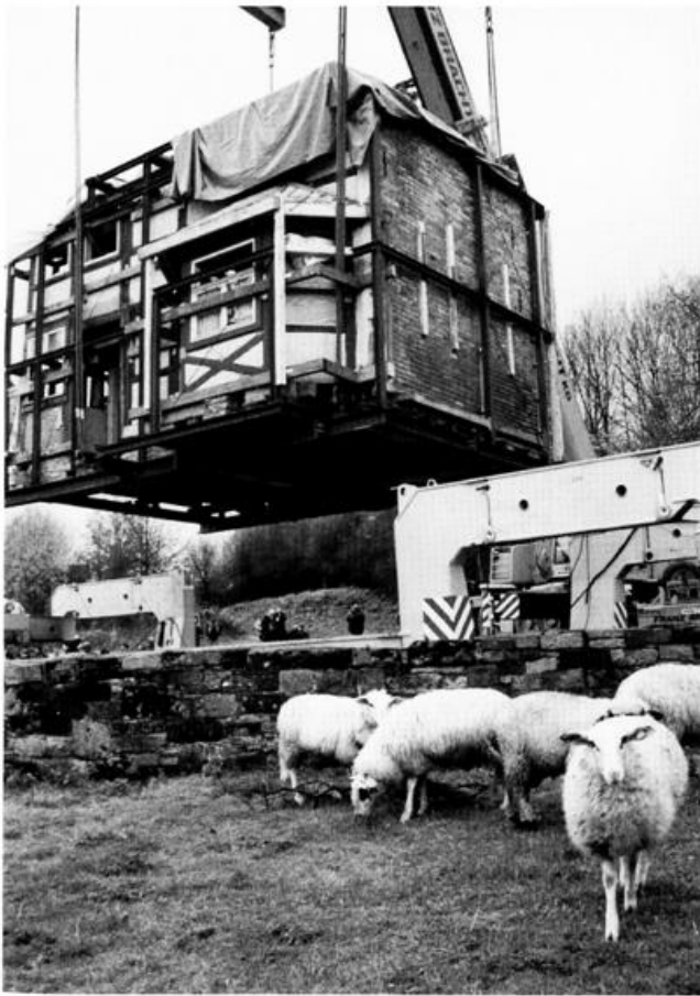
In der Schwebe: Translozierung des Hauses Uhlmann aus Ovenhausen ins Freilichtmuseum, 19. November 2000
