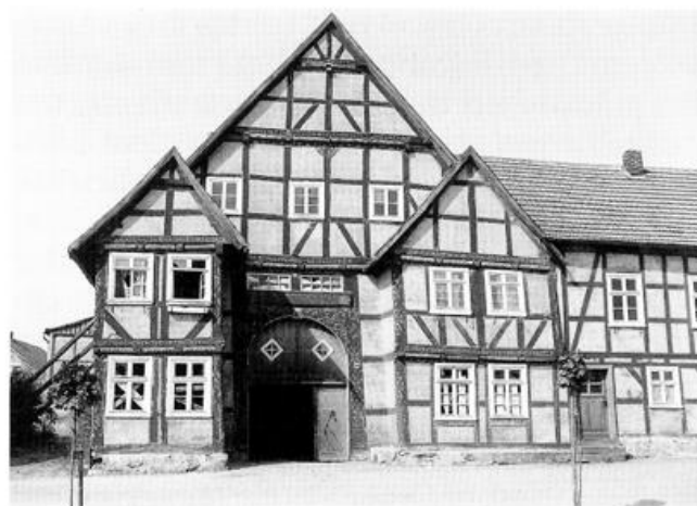
Abb. 20 Haus Hauptstr. 31 nach dem Auszug der letzten Bewohner, 1966. Links sind die Balken der Abstützungsmaßnahme von 1949 zu erkennen
