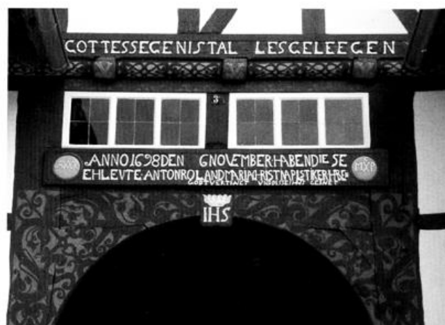
Abb. 6 Torinschrift mit den Namen der Erbauer von 1698 nach der Restaurierung im Freilichtmuseum
