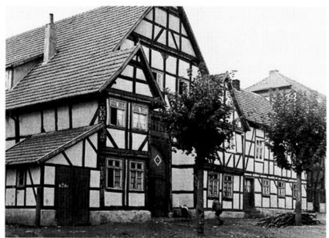
Abb. 19 Haus Hauptstr. 31 nach der Erneuerung des Daches mit Falzziegeldeckung und einer Gaube. Links ist die angebaute Viehwaage zu sehen. Foto um 1950
