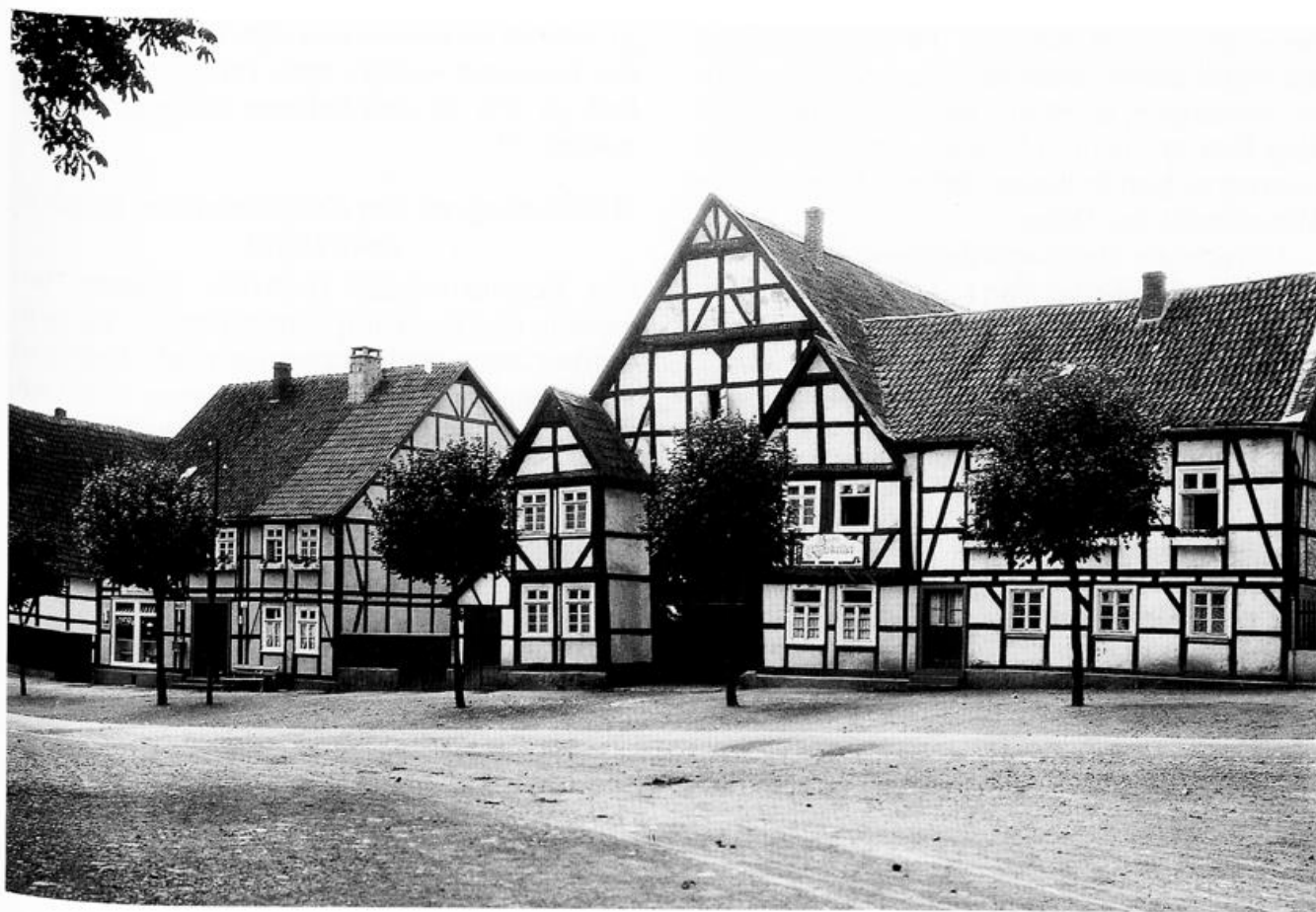
Abb. 16 Haus Hauptstr. 31 in Obermarsberg, 1928. Zu dieser Zeit befand sich das Haus im Besitz der Stadt und wurde weiterhin als Gaststätte verpachtet, die jetzt „Zum Ratskeller“ hieß
