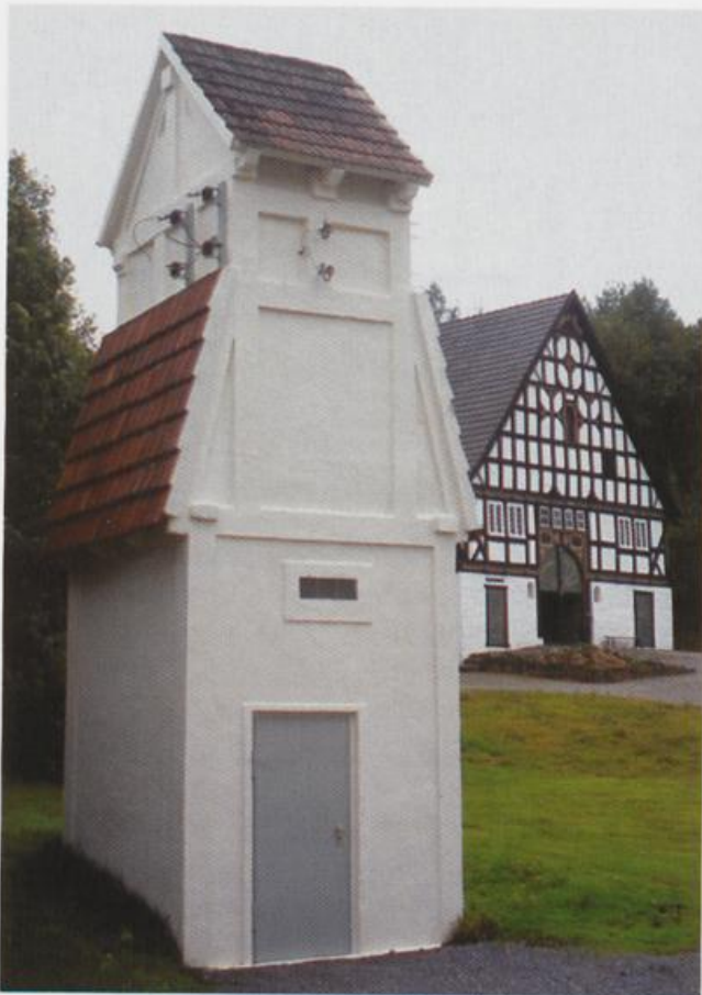
Abb. 13 Trafostation aus Niedermarsberg im Sauerländer Dorf des Freilichtmuseums
