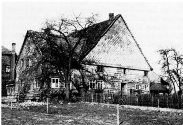
Abb. 72: Haupthaus von 1765. Rückseite mit angebautem Wohnflügel und Verkleidung.
