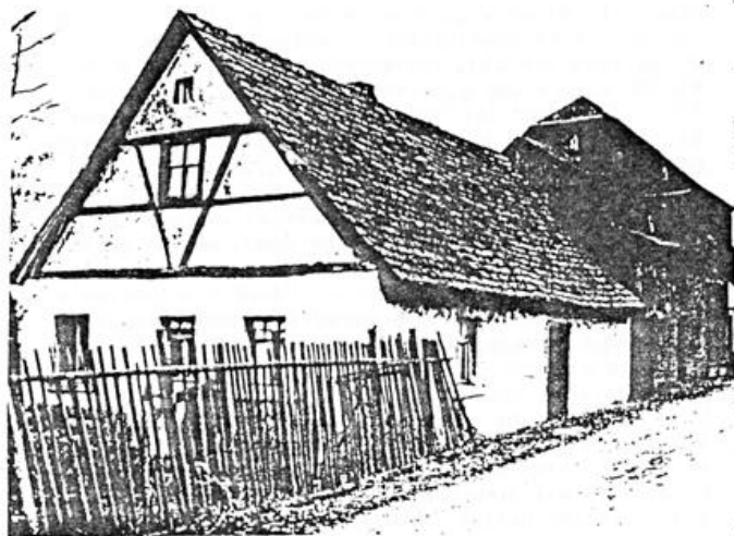
Das Lehmstockhäuslein mit angebauter Scheune.
