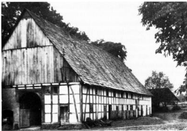
Abb. 13: Das große „Dreschhaus“ von 1809 mit Sollingplattendach, abgebrochen. Aufn. 1954.
