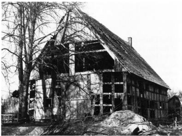
Abb. 68: Das Haupthaus von 1691 zu Beginn der Renovierung (1980).
