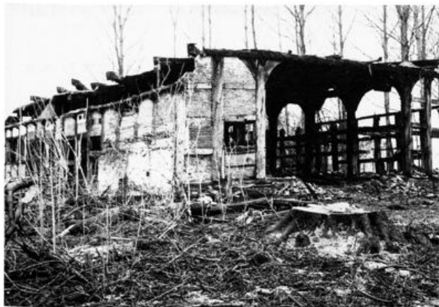
Abb. 51: Das Zweiständer-Haupthaus von 1668 während des Abbruchs im April 1983.
