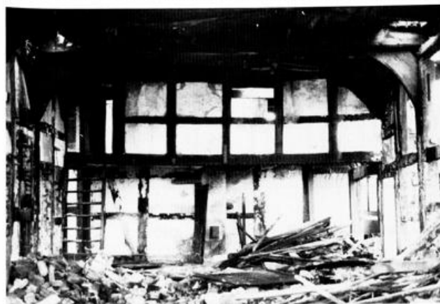
Abb. 52: Haupthaus von 1668. Flettdeele mit Räucherbühne im Abbruch.
