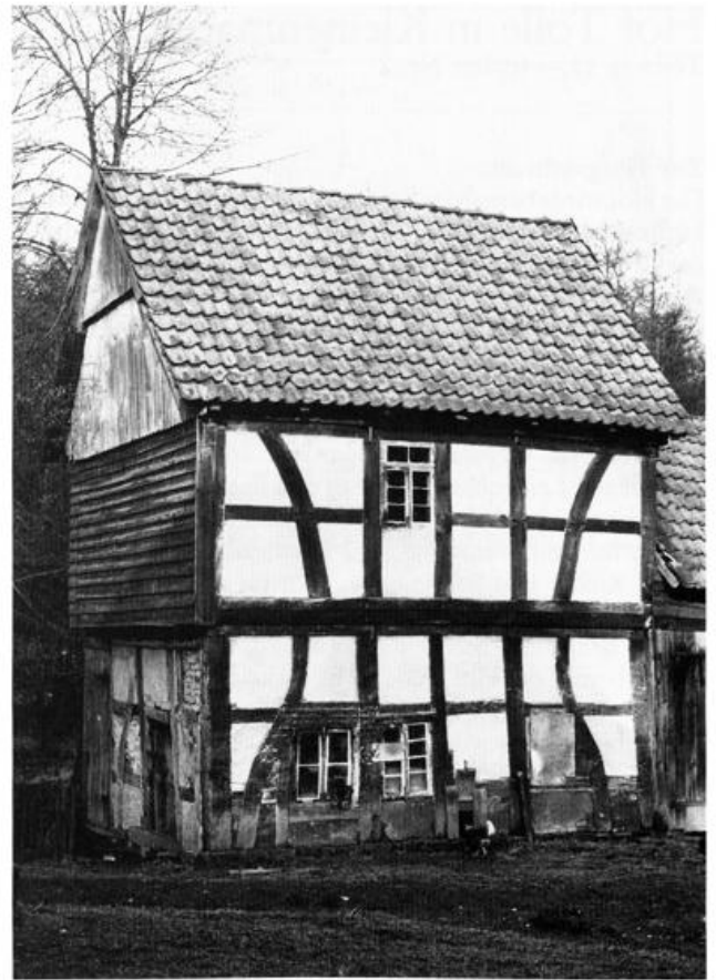
Abb. 41: Speicher von 1783, Zustand vor dem Abbruch 1984.
