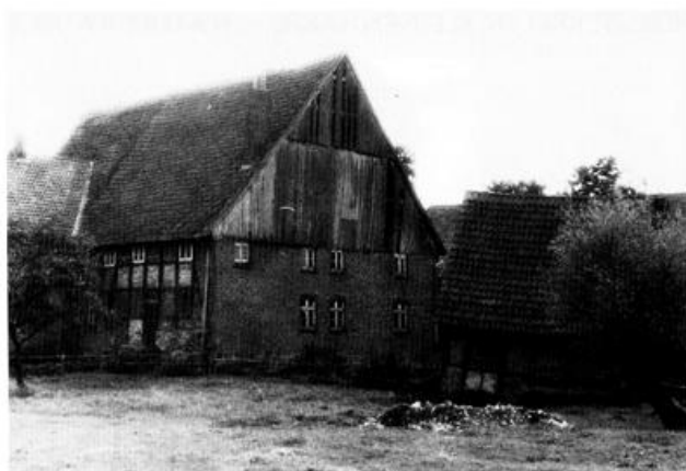
Abb. 36: Ansicht von Norden. Links Haupthaus mit massiv erneuertem Wohngiebel (um 1900), rechts Backhaus von 1812.
