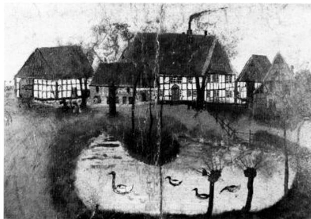
Abb. 23: Hof Potthoff in Brokhausen; Ansicht von Südosten. Ölbild um 1895.
