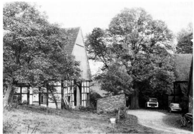
Abb. 25: Leibzucht und Speicher von Westen. Zwischen der Leibzucht und der großen Linde lag die alte Hofzufahrt.
